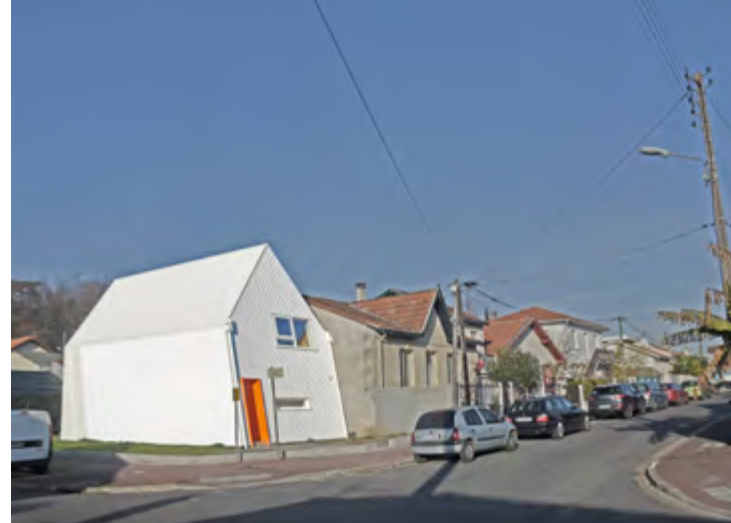
La forme penchée permet d'optimiser l'espace en créant de la hauteur.
